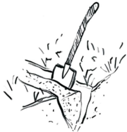
**F** Steche mit einem Spaten ca. 20–25 cm tiefe v-förmige Leitungsgräben aus. Nehme dazu vorsichtig die ausgestochene Grasnarbe ab und hebe den Graben aus. Entferne die Steine aus dem Graben.
